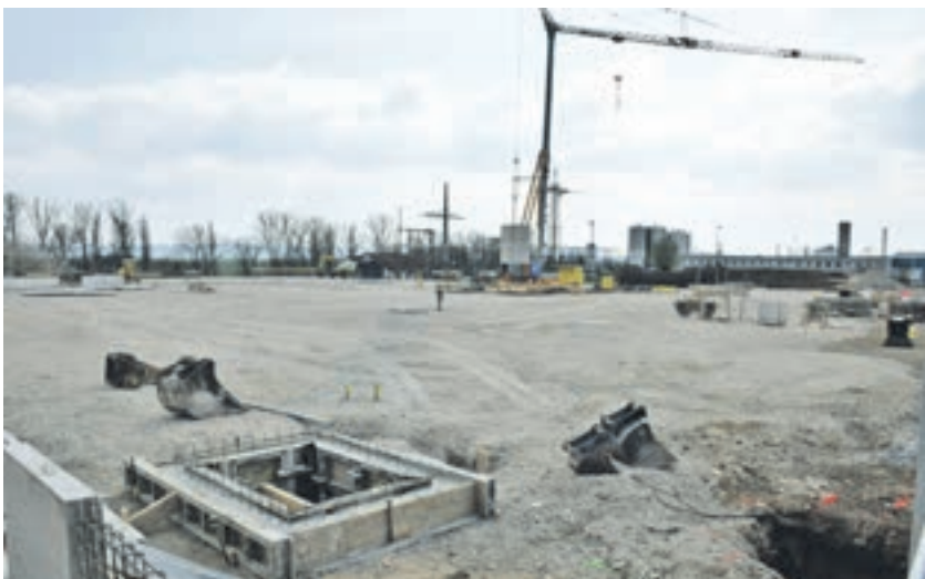
So sah es in einer frühen Bauphase aus.
